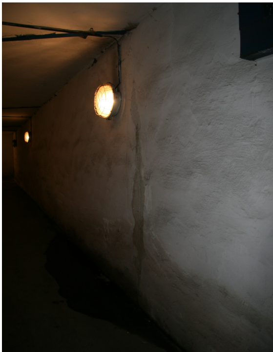
Foto č.5 - Pohled na opěru - zvlhlá omítka, protékající dilatační spára.
