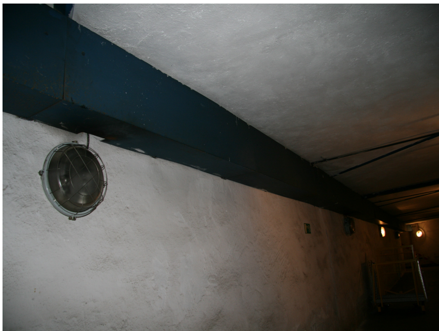
Foto č.4 - Pohled na kabelový žlab.
