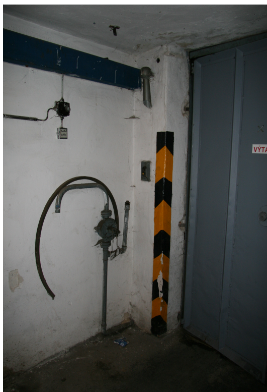
Foto č.6 - Pohled na nákladní výtah na III. nástupišti - čerpadlo na čerpání vody z jímky ve výtahové šachtě.
